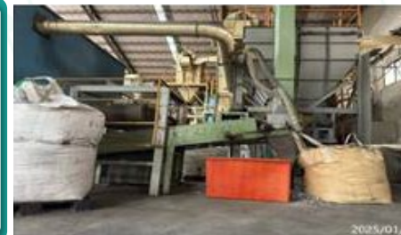
進行破壞作業
